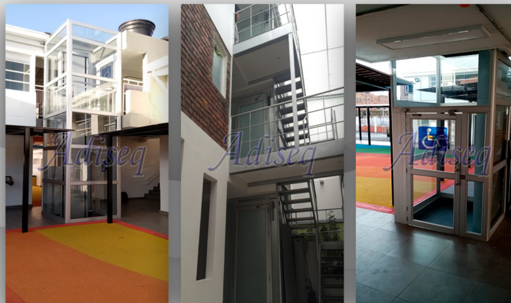
Elevador tipo panorámico
